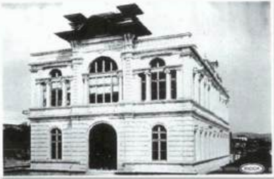
Liman İdare Binası
