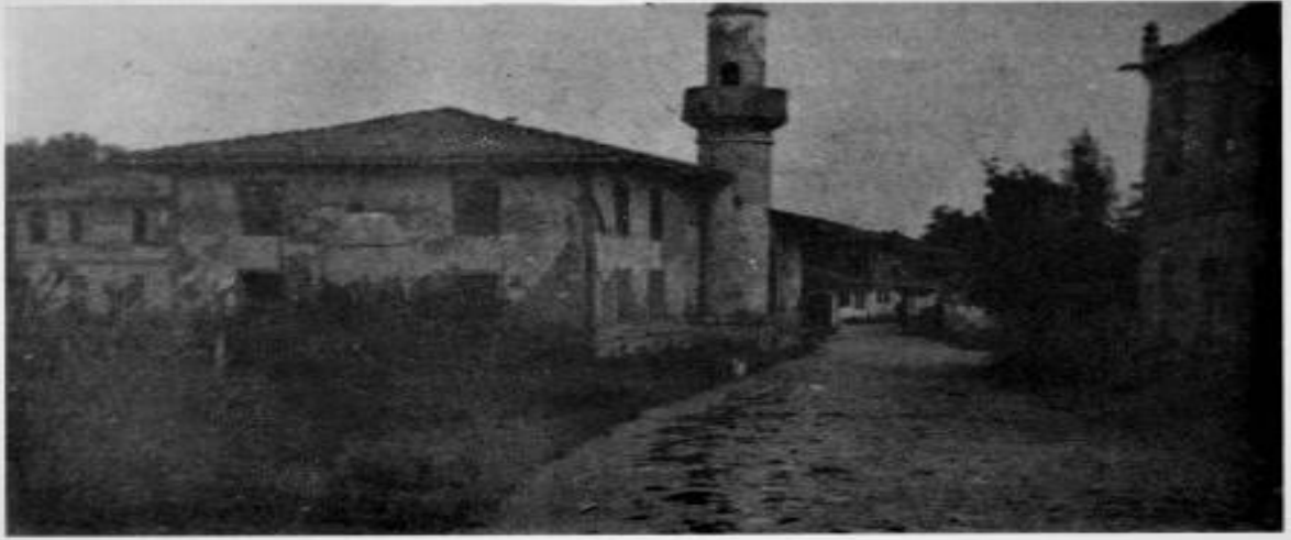
Şekil:-- Ahî Hasan Mahallesiinde Temelsiz Câmî' Sene 1335(M.1916)
