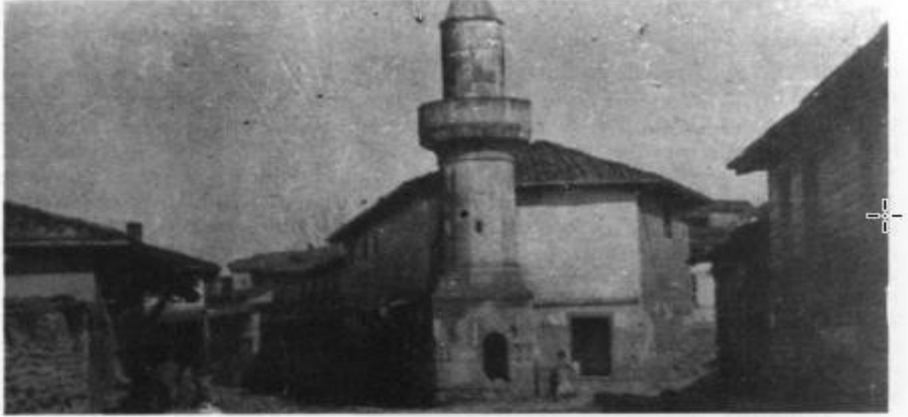
Şekil:-- Umur Bey Mescidi (Sokağa açık olan minare kapısı yanındaki açık kapıdan mescide girilir.
